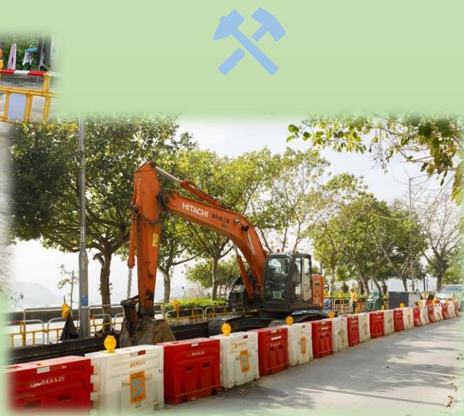
沙頭角墟污水渠鋪設工程 Sewers Laying at Sha Tau Kok Town
