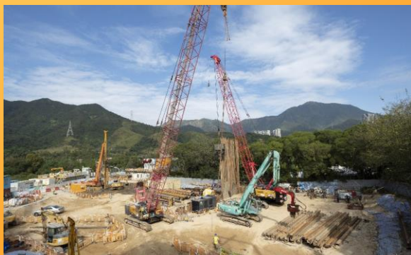
新建污水處理廠的地質鑽探及地基建造成工程 Pre-drilling and Foundation Works for the new STW
